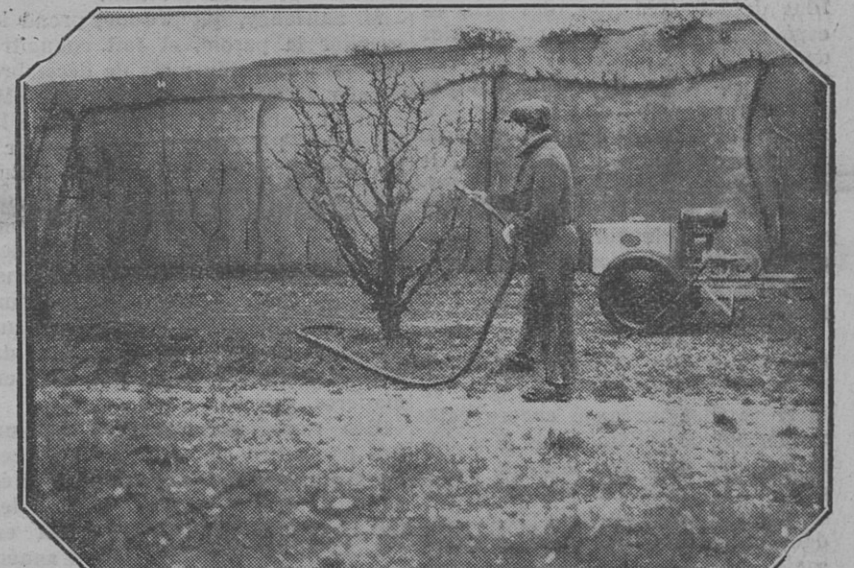
Un pulvérisateur à moteur « Cardelle » en action. Les arbres sont ici traités avec une solution d'Ivernol, produit colorant jaune.
