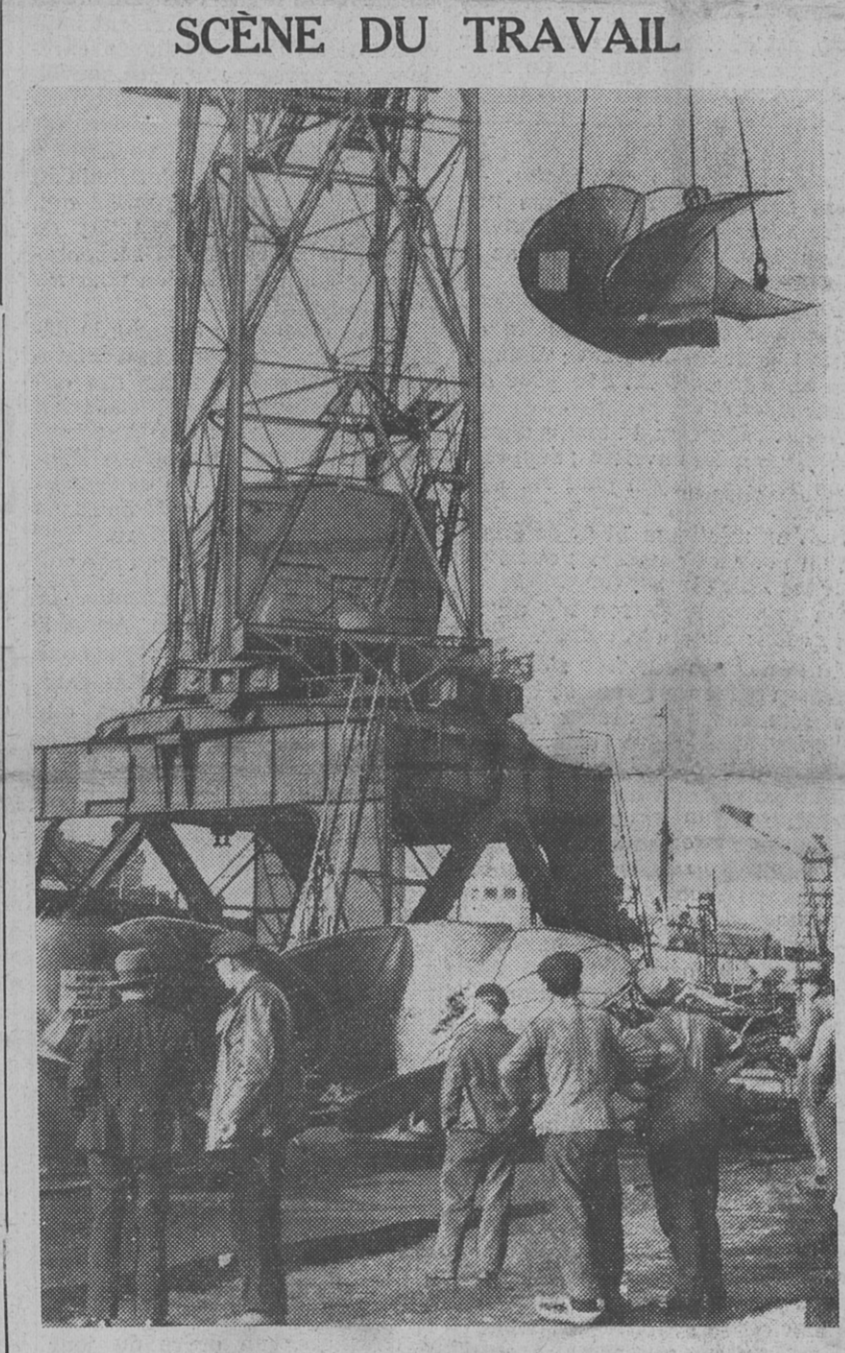
La mise en place d'une hélice
