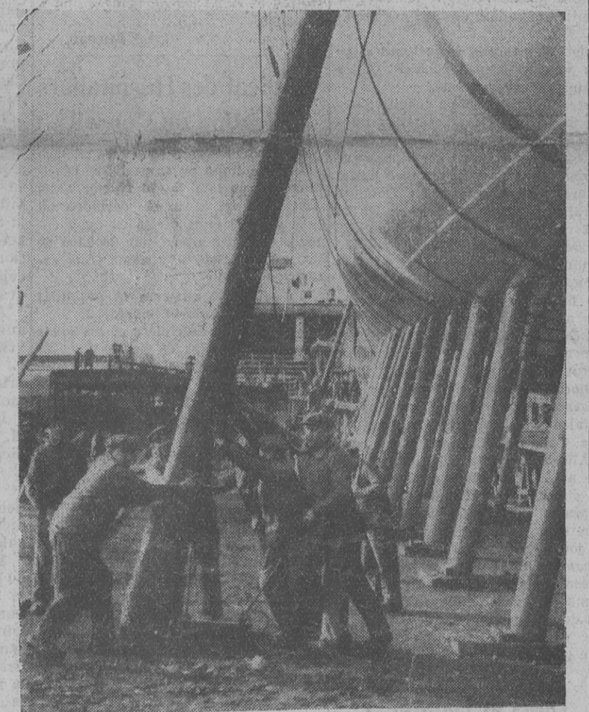
EES « DESSOUS » D'UN LANCEMENT Les ouvriers retirent les derniers étais
