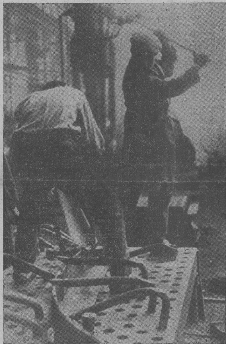
Forgerons en cornières au travail
