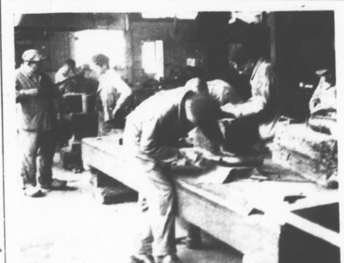
L'atelier des apprentis chaudronniers à l'Arsenal d'Indret
