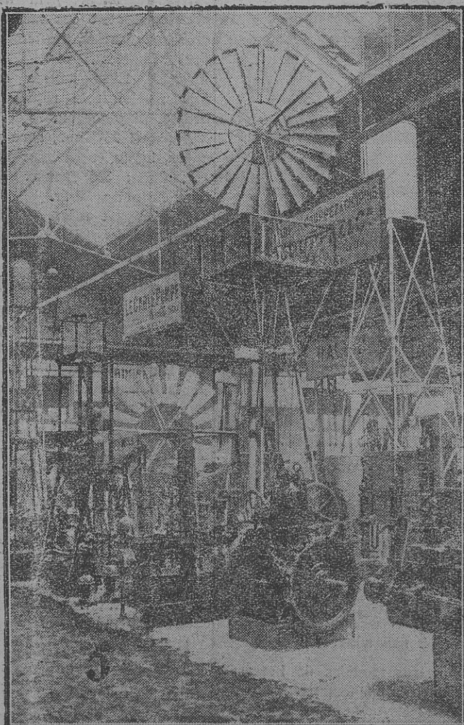
Un coin de pompes avec moteurs ou éoliennes
