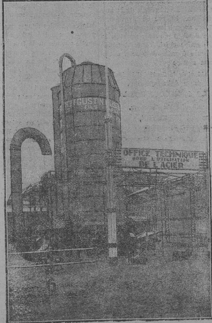
Les silos d'acier et les carcasses de hangars
