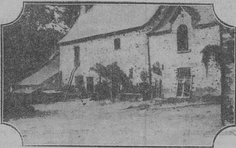
Une vue de la ferme de M. Pierre Gaultier, au Gué du Moulin-Roult, à Soudan (Loire-Inférieure).
